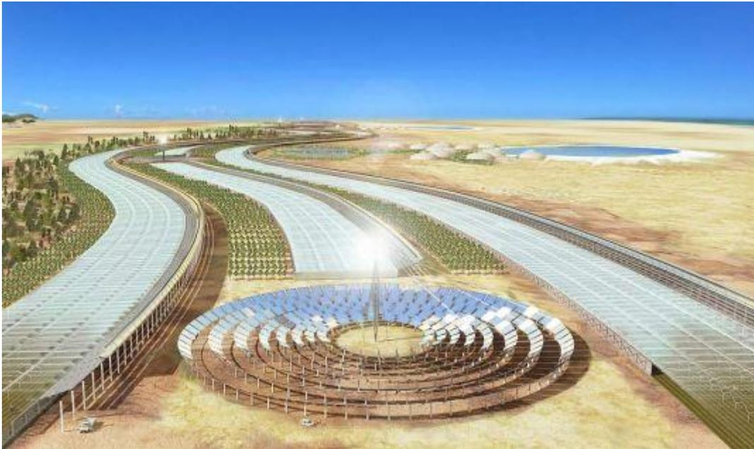
Endlos zieht sich ein Band von Photovoltaik-Elementen durch die Wüste. Sie dienen zugleich als Dachflächen von Riesenglashäusern, wo Wüstenluft an einem Kondensator abkühlt und die kaum messbare Feuchtigkeit einem unterirdischen Sammelsystem zugeführt wird. Ein Solarkraftwerk
